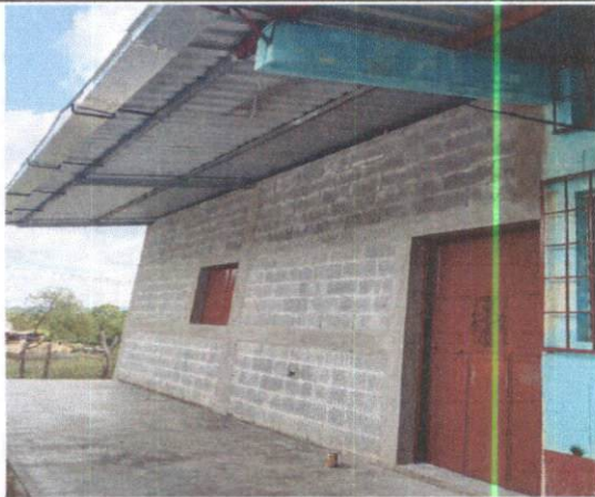
Foto 3: Área donde se contempla mejoramiento con estructura tipo pórtico e instalaciones de laminas troquelada calibre "26" ya finalizado.
