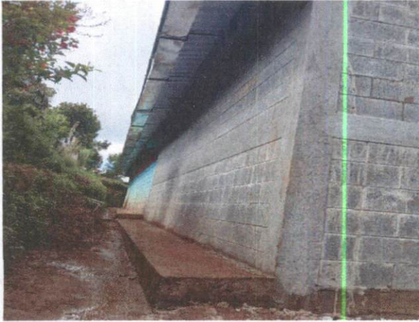
Foto 1: Área donde se contempla la realización y finalización de banqueta, en el área de atrás de la estructura tipo portico.
