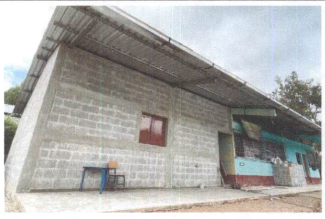
Foto 4: Área donde se contempla mejoramiento con estructura tipo pórtico e instalaciones de laminas troquelada calibre "26" ya finalizado.
